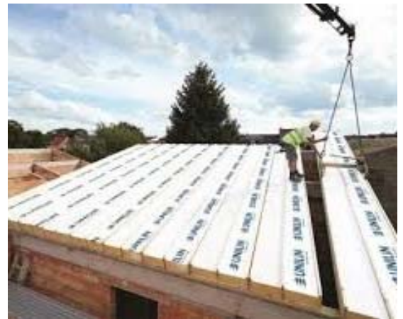
Caissons chevrons préfabriqués
