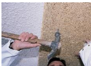
Isolation par plaque de fibrastyrène fixées mécaniquement Source : Knauf
