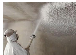
Isolation par flocage en sous-face Source : Europ-isolation
